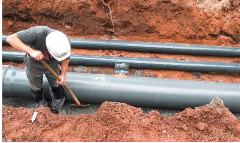
Für Sanierungen in offener Bauweise, wird der Boden aufgedigert.
